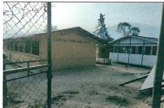
Foto 2: Losa de patio
