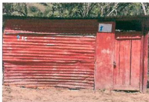
Foto 4: Servicios Sanitarios y suls accesorios
