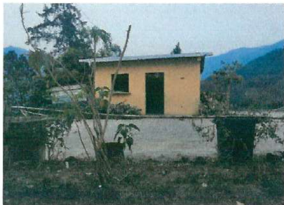
Foto1: Estructura de techo modulo 4 y patio
