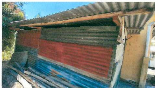
Foto 2: Cubierta de lamina
